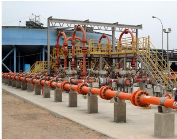
Figura 3.3 – Estação de válvulas (Collahuasi, 2008)
