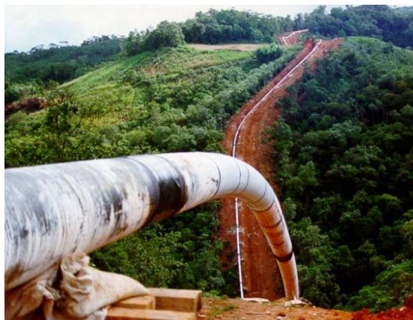
Figura 3.4 – Instalação da tubulação principal (Brass Engineering, 2008)
